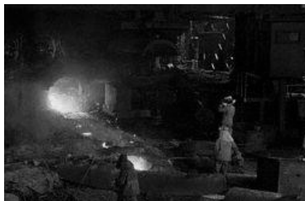
Figura 74: Calha da corrida do gusa.
